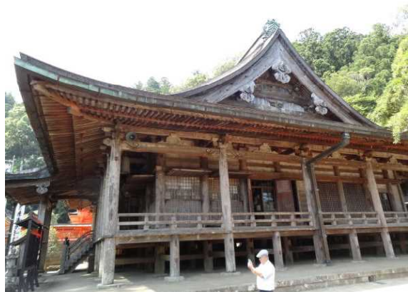
破壊を免れた那智山青岸渡寺
